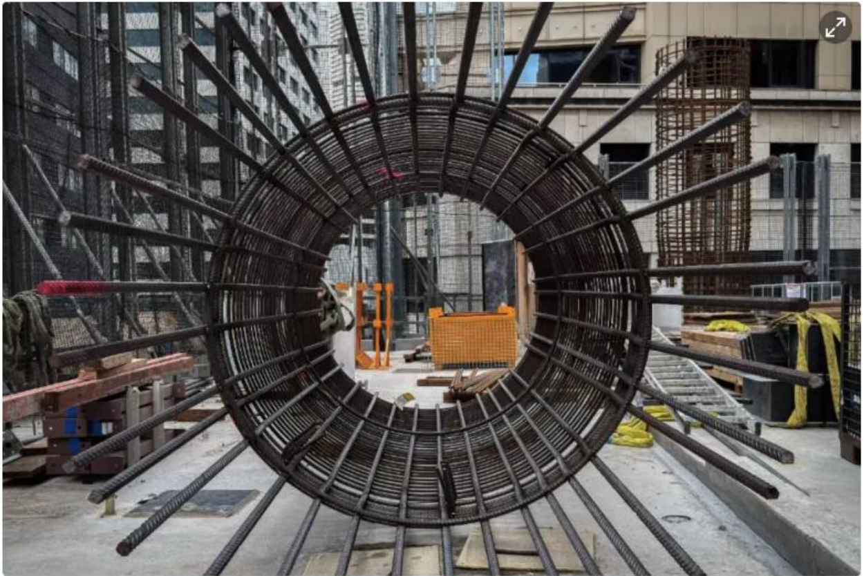
澳大利亚InfraBuild研发的Sense 600钢筋，在维持承重的同时，能减少材料用量。（取自SG Mark官网）
